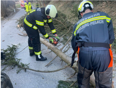
Sturmschaden in Pielach
