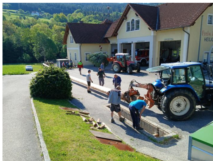
Vorbereiten des Schachtes
