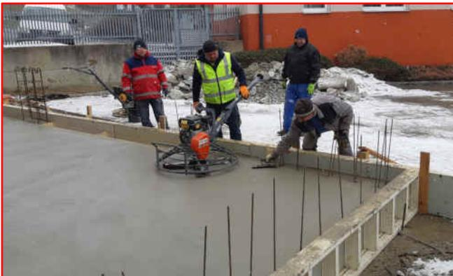
26. Jänner: Bodenplatte betonieren und flügeln.
