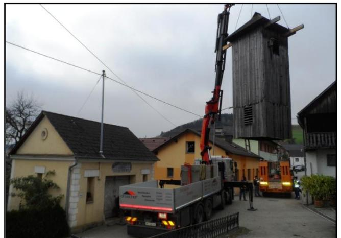
Die obere Hälfte wurde mit der Motorsäge abgeschnitten und mittels Kran heruntergehoben.
